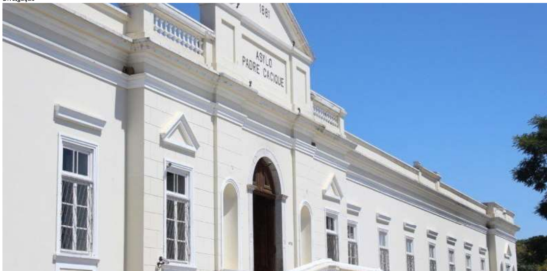
A ação solidária de sanitização atua na desinfecção de paredes, pisos, equipamentos e outras superfícies.
